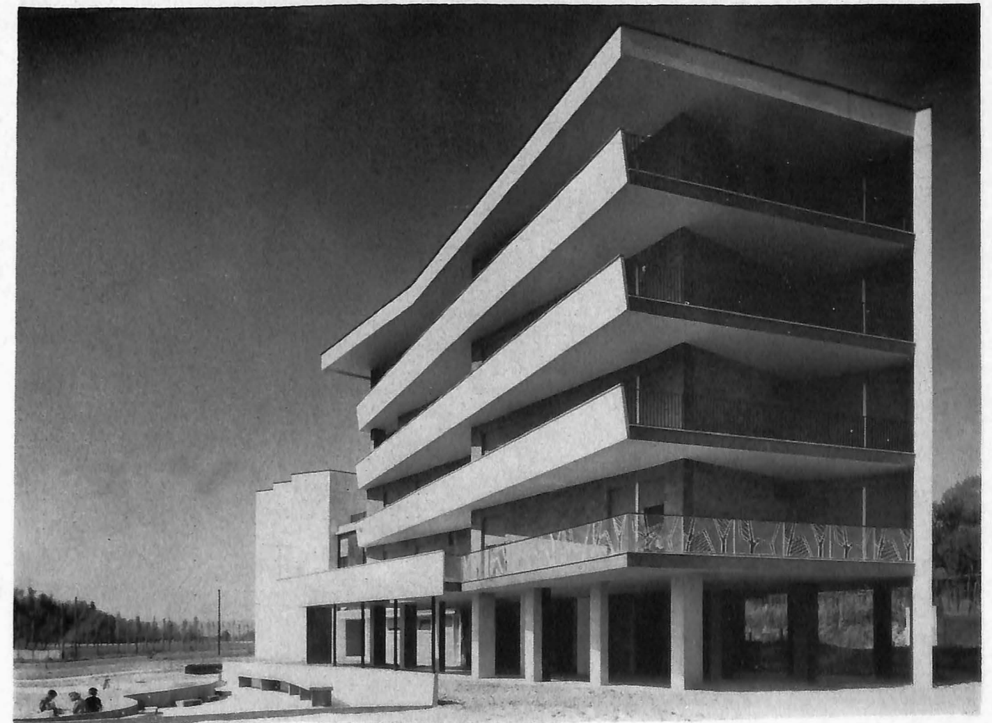
Edificio de dieciocho departamentos, para trabajadores de la Olivetti, en Ivrea. Arquitecto Nizzoli.
