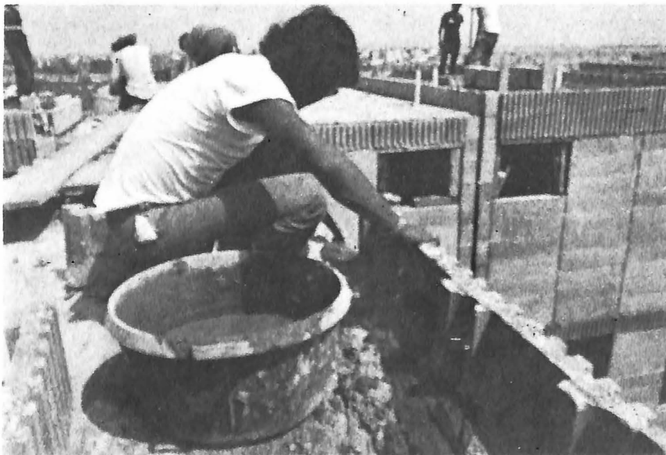
El sistema de autoconstrucción utiliza como material básico el concreto; éste puede ser prefabricado, pretensado o colado en el lugar.
