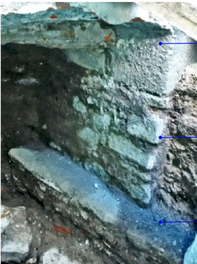
Pérdida de sección y exfoliación en la mampostería del basamento
