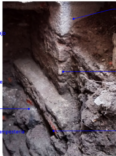
Pérdida de sección y exfoliación Zapata y base de zapata
