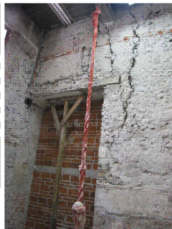
Figura 1 Estado actual de vano existente
