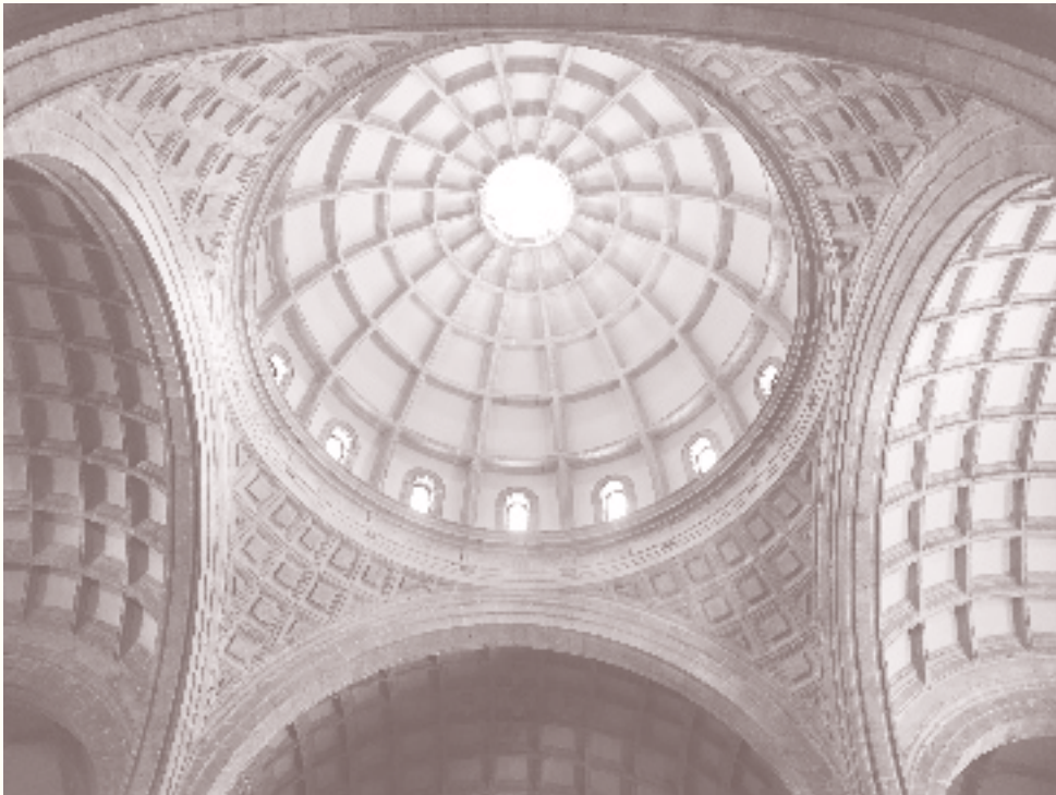
Bóveda de la Catedral de Mérida. Fotografía: Xavier Cortés Rocha, 2019.
