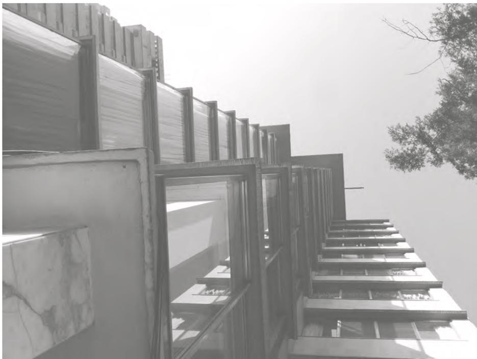
Vista parcial de la fachada del edificio de Horacio 1834, 2016. Se observa el tratamiento de los salientes de las losas de entresuelo, con un faldón a manera de gotero. Asimismo, destaca lo pronunciado de la losa de remate y la pluma para izar muebles.
