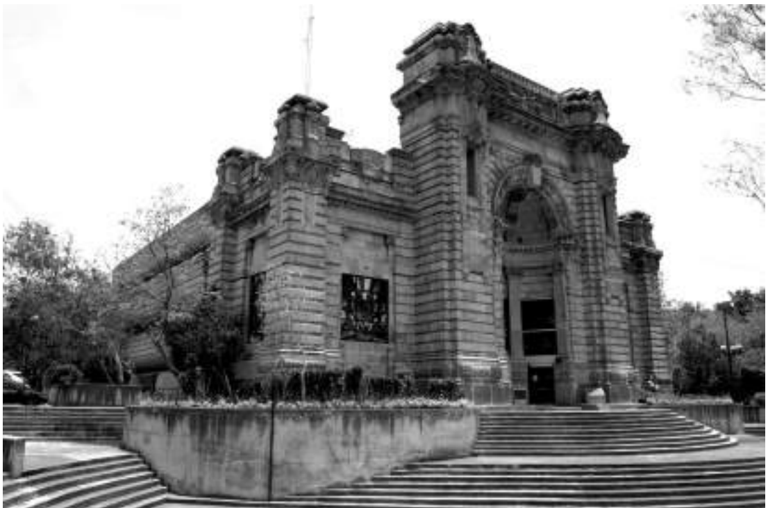
Fachada de la planta de bombas número 1 reconstruida en la Casa de la Cultura de Tlalpan. Fotografía: MLDH, junio de 2017.
