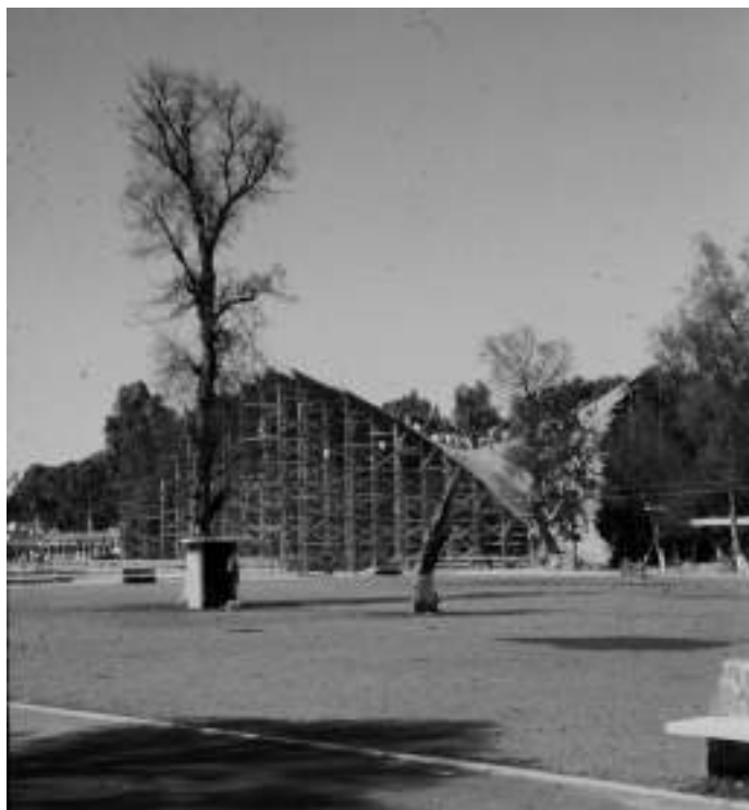
Paraboloide hiperbólico para el Parque Asturias, colonia El Reloj, Coyoacán, Ciudad de México (armado de la cimbra). Fuente: FHC, 1959.
