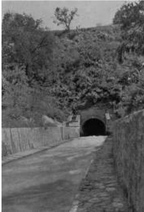
Obras del desagüe del Valle de México. Túnel en la barranca de Acatlán, Tequixquiac. Fuente: Ciudad de México. Breve guía ilustrada (México: Imprenta y Fototipia de la Secretaría de Fomento, 1906).
