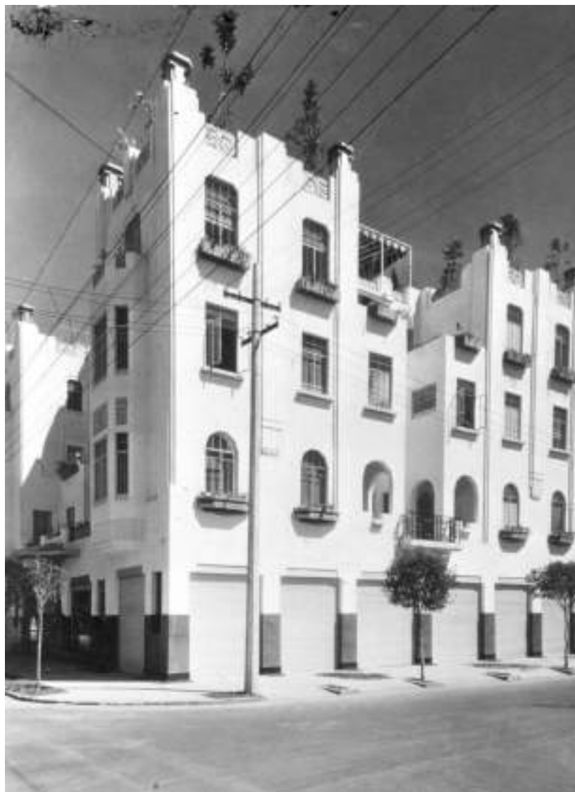
Edificio Casas Jardines (1928-1930), cruce de las avenidas Ámsterdam y Sonora, Hipódromo de la Condesa, Fuente: AAM/FA, UNAM, Fondo "Francisco J. Serrano".
