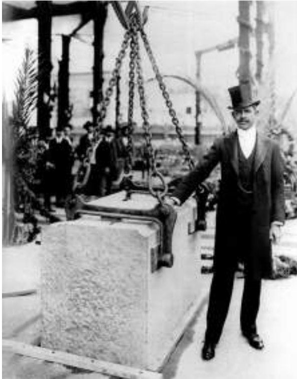
Gonzalo Garita en la construcción del edificio de Correos. Fuente: Francisco Arturo H. Schroeder Cordero, En torno a la plaza y el Palacio de Minería (México: UNAM, 1988), foto núm. 29.
