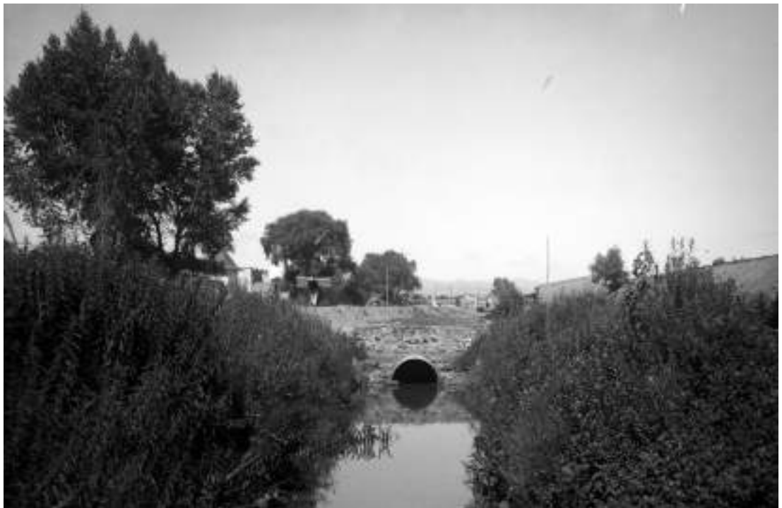
Obras de desagüe en avenida Insurgentes, 1927. Fuente: Dirección General de Servicios Técnicos de la Secretaría de Comunicaciones y Transportes (DGST).
