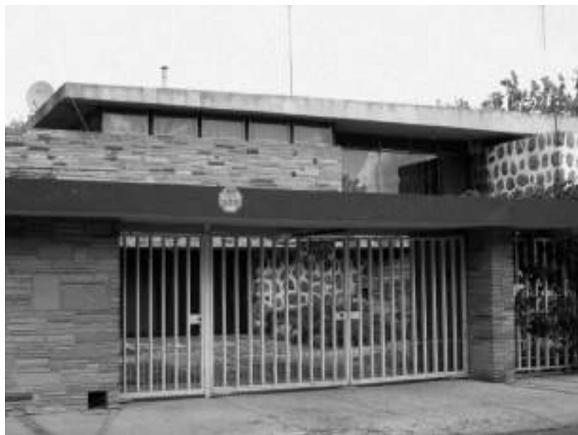
Casa Madrigal Salazar, demolida en 2012. Fotografía: JVR, agosto de 2002.
