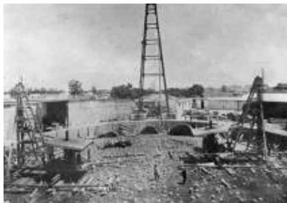
Dos vistas del proceso de recimentación del Monumento a la Independencia. Fuente: Fototeca Constantino Reyes Valerio, Coordinación Nacional de Monumentos Históricos, INAH, número de clasificación: CDII-34 y CDII-35.
