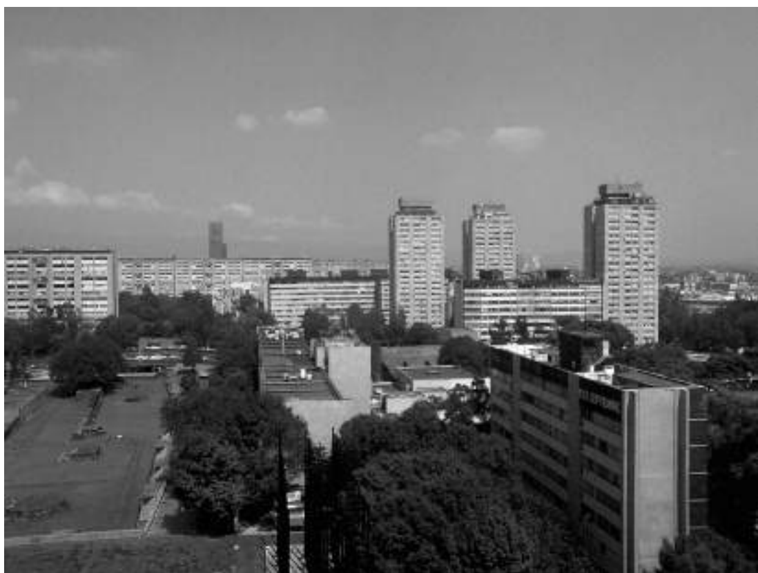
Vista reciente del Conjunto Urbano Ciudad Tlatelolco, en Av. Insurgente Norte, Ciudad de México. Fotografía: PSAL, noviembre de 2017.
