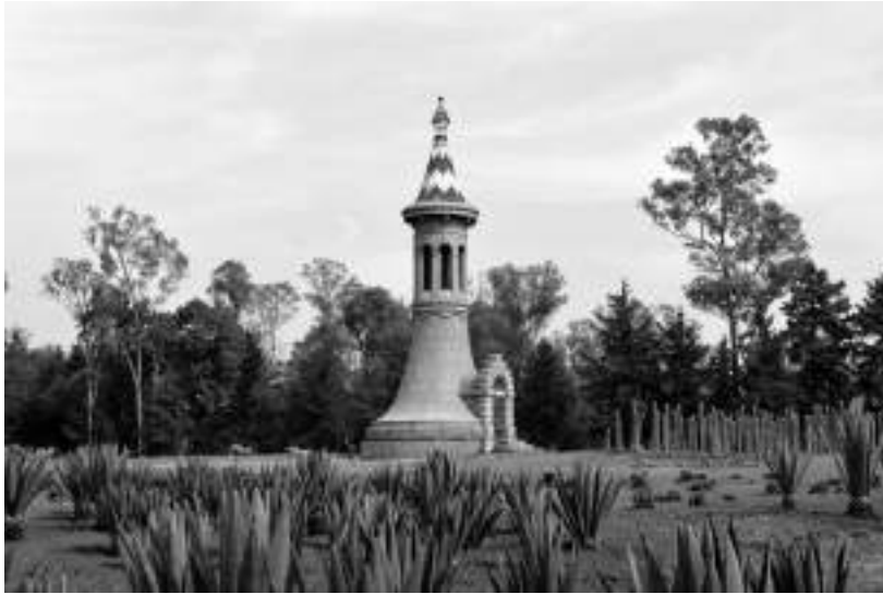
Entrada y ventilación a uno de los cuatro tanques de almacenamiento de agua potable en Chapultepec. Fotografía: María de Lourdes Díaz Hernández (MLDH), junio de 2017.
