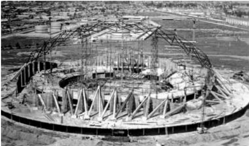
Construcción del Palacio de los deportes en Av. Churubusco y Río de la Piedad, Ciudad de México, obra de los arquitectos Félix Candela, Antonio Peyri y Enrique Castañeda, y revisión estructural y sísmica de Emilio Rosenblueth, 1968. Fuente: "Palacio 68" y "Alberca 68", Calli Revista Analítica de arquitectura Contemporánea , 30 (noviembre-diciembre de 1967).
