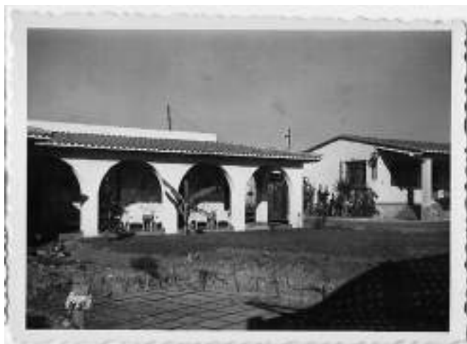
La Posada Vista Bella. Fotografía histórica cortesía del ingeniero Jaime Sandoval Walter.
