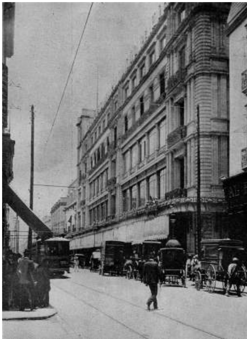
"Fachada del edificio de 'El Palacio de Hierro', hacia la calle de San Bernardo", anuncio comercial. Fuente: El Mundo Ilustrado , 18 de septiembre de 1904, p. 62.
