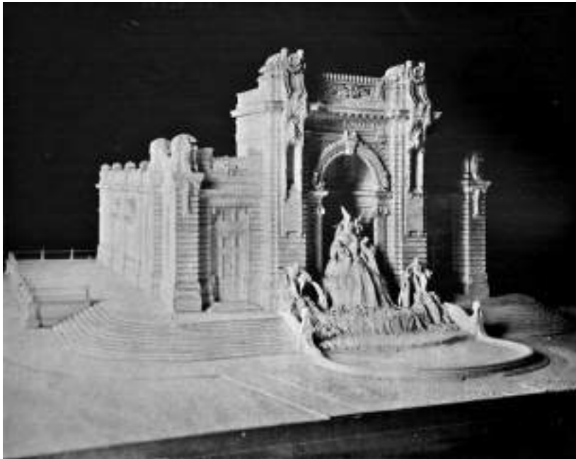
Maqueta de la planta de bombas número 1, donde se apreciaba la fuente central. Fuente: Memoria descriptiva de las obras de provisión de aguas potables para la ciudad de México , 1914.
