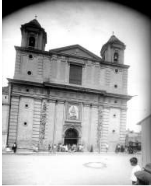
Antigua Iglesia de Loreto, con una inclinación de aproximadamente un metro, ca. 1924. Fuente: DGST.
