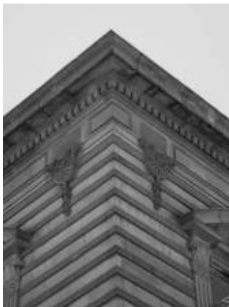
Vista y detalles de la casa Verástegui, San Luis Potosí. Fotografías: JVR, junio de 2013.
