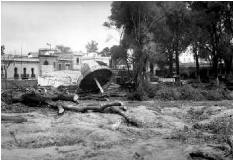
Demolición de los jardines de El Tívoli del Eliseo. Fuente: Fototeca Nacional del INAH.
