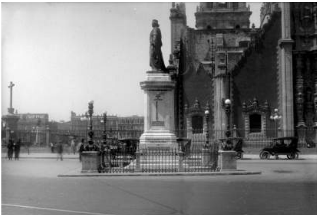
Monumento Hispográfico (1881) en el costado izquierdo de la Catedral de México (a mediados de la década de 1920 se trasladó al costado derecho). Originalmente el pedestal de la escultura contaba con indicadores que medían el nivel de las aguas del Lago de Texcoco. Fuente: DGST.
