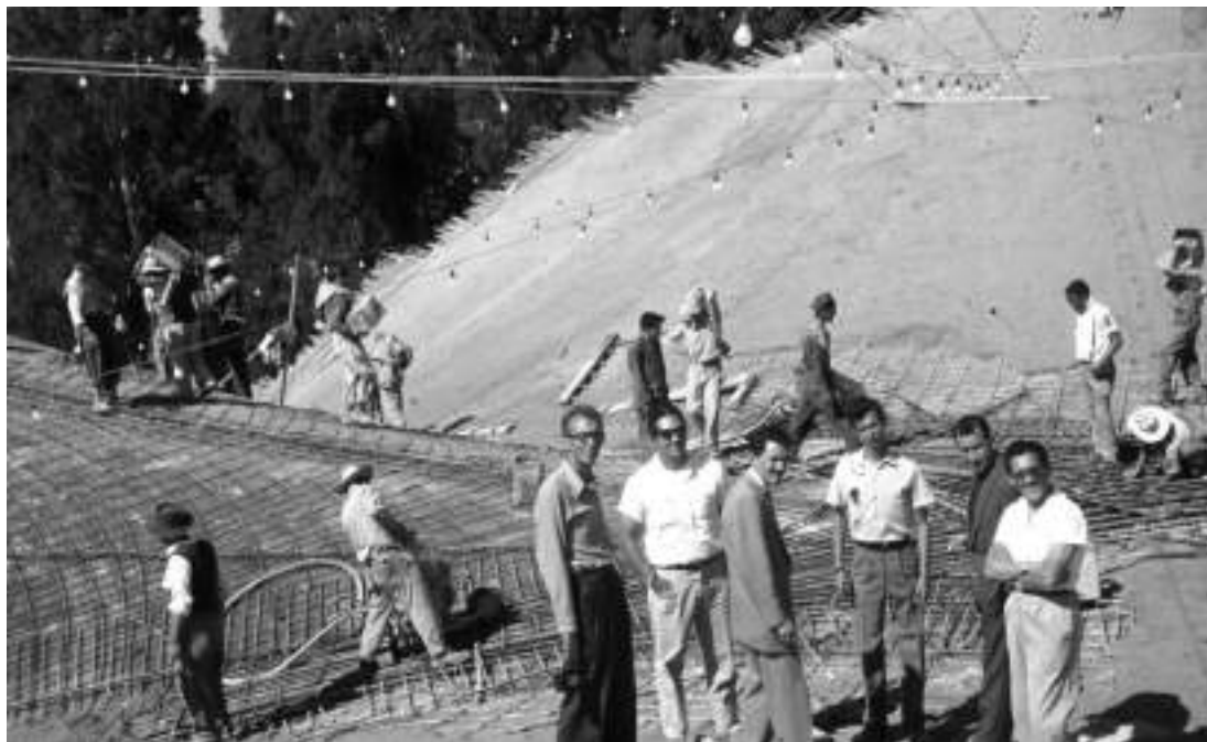
Construcción del paraboloide hiperbólico para el Parque Asturias, colonia El Reloj, Coyoacán, Ciudad de México. El primero de izquierda a derecha es el ingeniero Heberto Castillo. Fuente: FHC, 1959.
