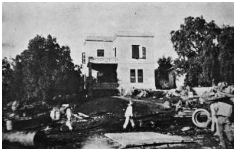
Casa de concreto para el mecánico, en Nativitas. Fuente: Memoria descriptiva de las obras de provisión de aguas potables para la ciudad de México, 1914.
