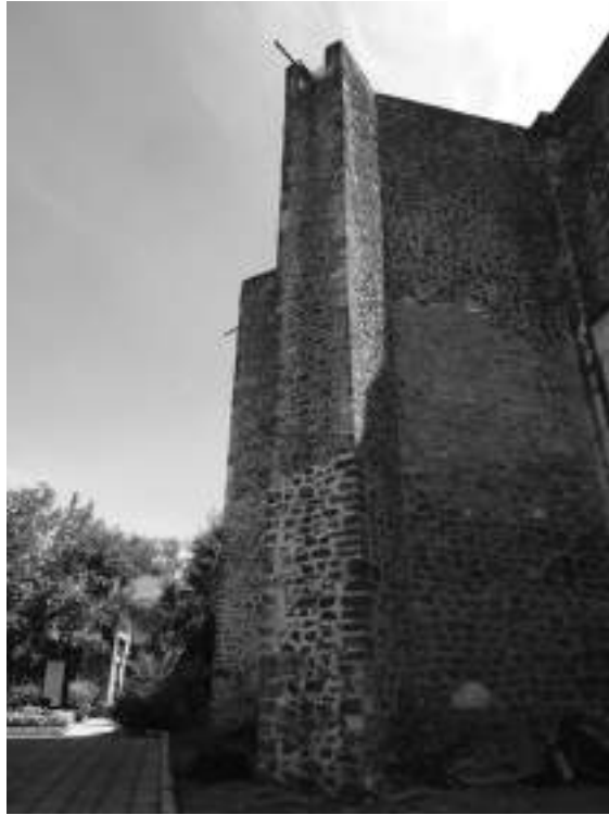
Contrafuertes de la iglesia de Santo Domingo del convento de Oaxtepec. Fotografía: Louise Noelle, febrero de 2017.
