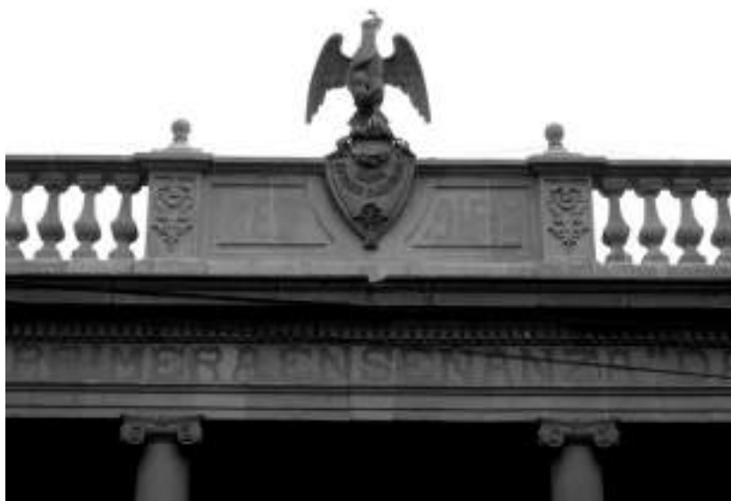
Vista actual del pórtico y detalle del escudo del edificio para la Exposición Industrial y Agrícola (1907). Fotografías: JVR, julio de 2014.
