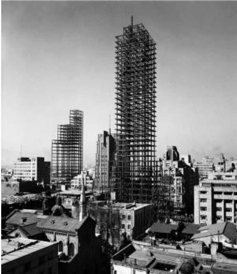
Torre Latinoamericana en construcción. Fuente: Cortesía Fondo Guzmán, 1950. Fundación Televisa.
