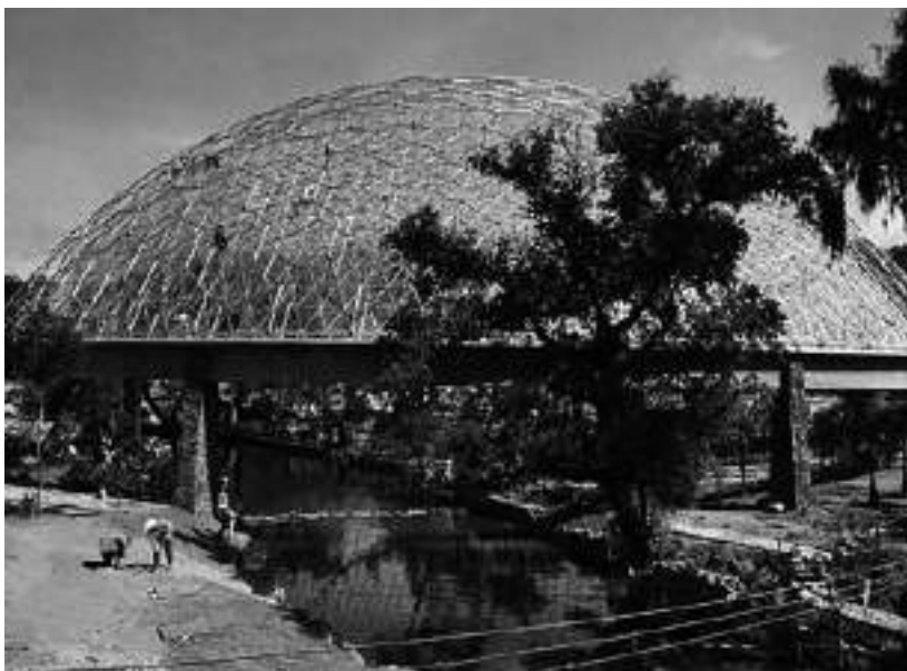
Cúpula Geodésica en el Centro Vacacional Oaxtepec, Estado de Morelos, ca. 1967. Fuente: CDBSA.
