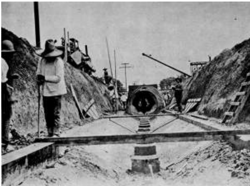
Acueducto entre Santa Cruz, Xochimilco y la colonia Condesa, 1910. Fuente: Obras de provisión de aguas potables para la ciudad de México (México: Imprenta dirigida por Juan Aguilar Vera, 1910).
