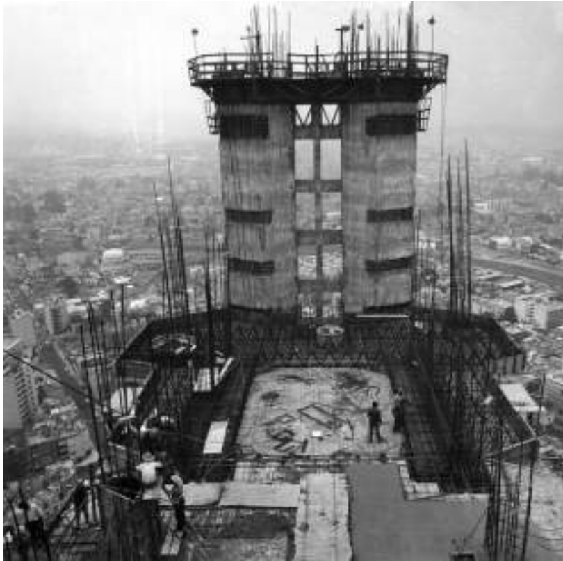
Vista del armado para el Hotel de México (hoy World Trade Center), en avenida Insurgentes Sur, colonia Nápoles, Ciudad de México. Fuente: FHC, 1970.
