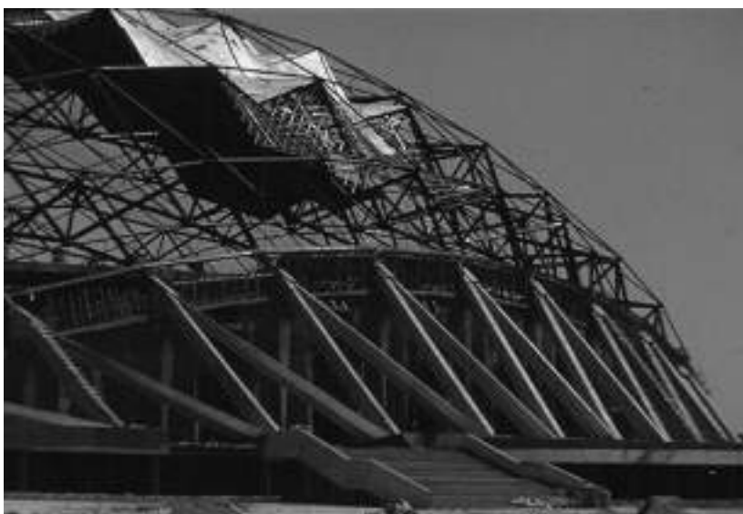
Proceso constructivo del Palacio de los Deportes, Ciudad de México, ca. 1967. Fuente: CDBSA.
