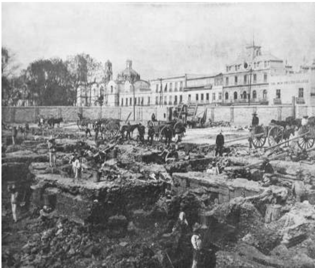
Trabajos de cimentación en el subsuelo del Teatro Nacional, posteriormente llamado Palacio de las Bellas Artes.
