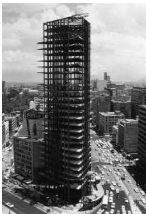
Proceso constructivo del nuevo edificio de la Lotería Nacional, centro de la Ciudad de México, ca. 1970. Fuente: CDBSA.
