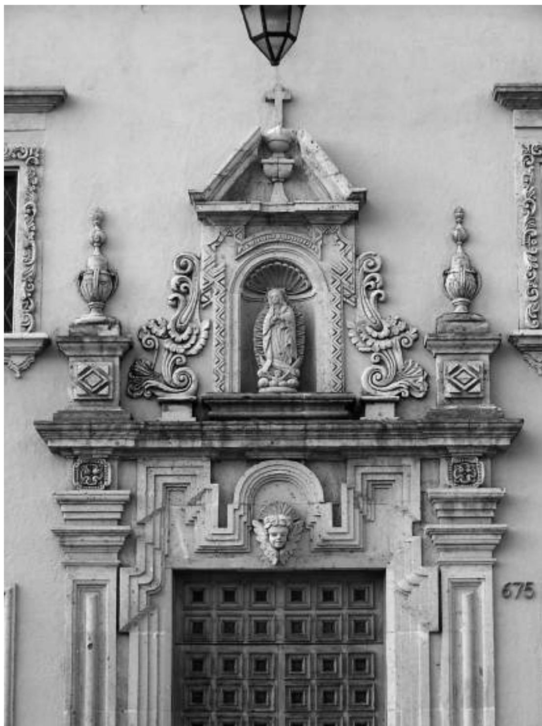
Detalle de la fachada de la casa Sandoval en Morelia en una vista reciente. Fotografía: ce, abril de 2017.
