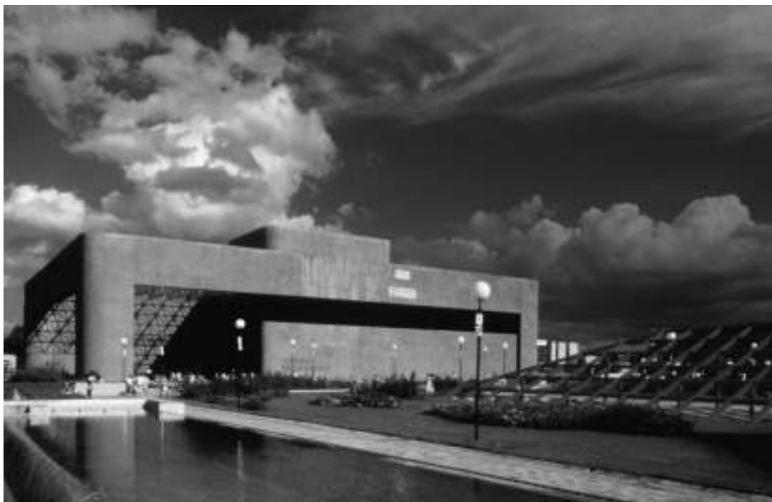
Teatro de la Ciudad de Monterrey dentro de la Macroplaza, del arquitecto Oscar Bulnes, 1984. Archivo Louise Noelle.
