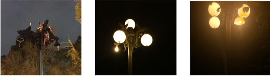
Figura 35. Luminarias con alteraciones en su funcionamiento
