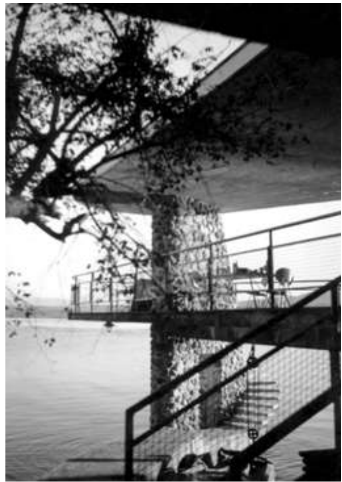
Fig. 32 Acceso a la terraza en la Casa Quintana en la ribera del lago de Tequesquitengo, 1948, fotografía de Max Cetto.
