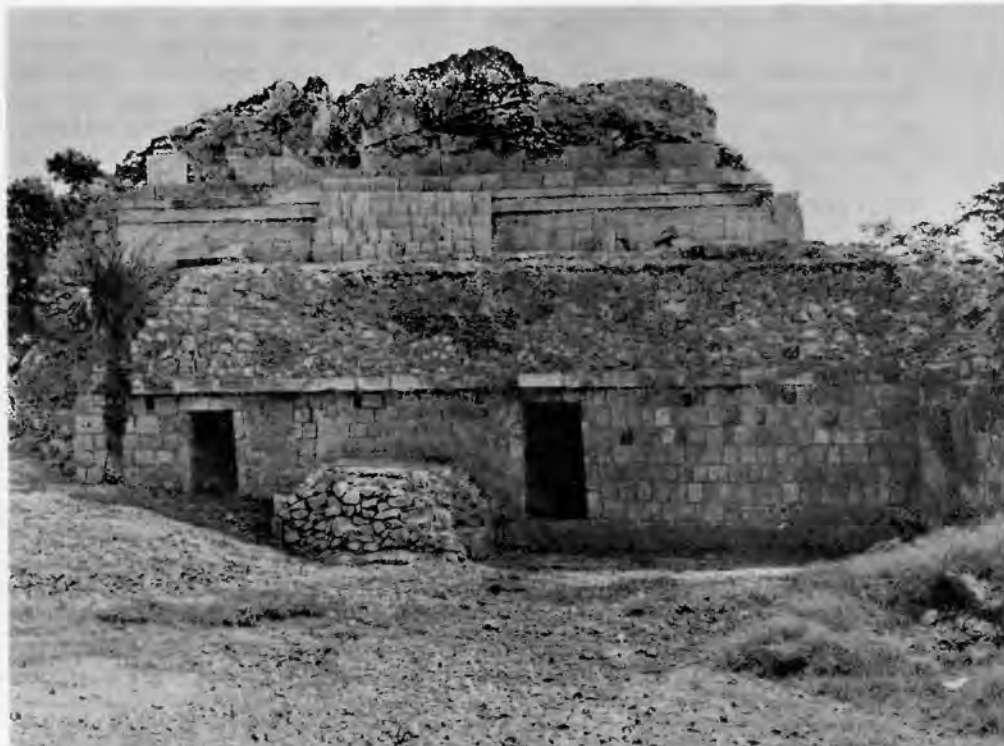
6. Edificio 20 de Chacmultún (Grupo Xethpol) visto desde el poniente tras las labores de consolidación.
