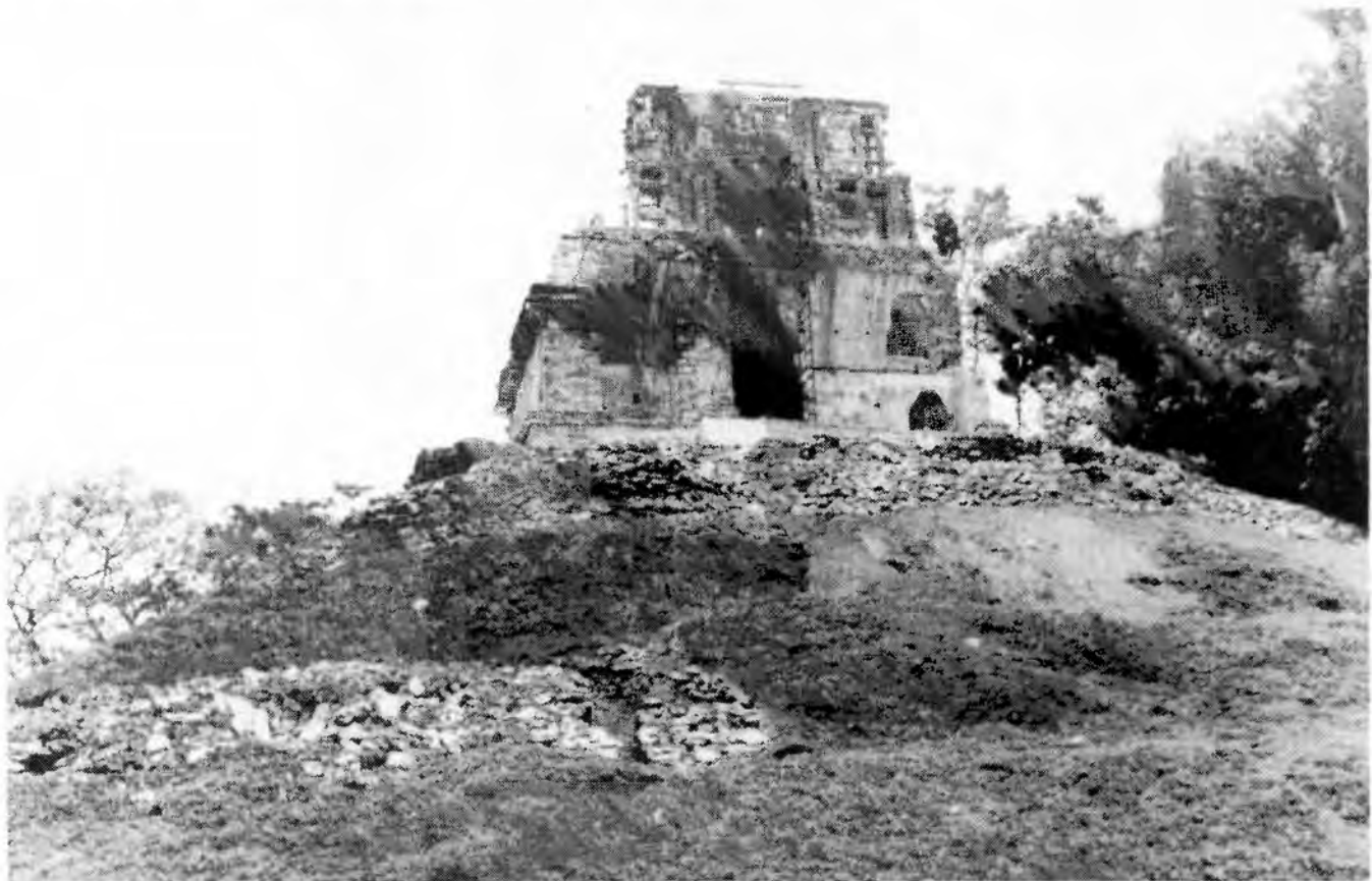
6.- Templo de la Cruz, en Palenque, Chiapas. Se puede apreciar la amplitud del espacio interior a base de sistemas de aligeramiento en la bóveda. 7.- Templo de la Cruz Foliada, Palenque, Chiapas. Fotos de Juan Antonio Siller.
