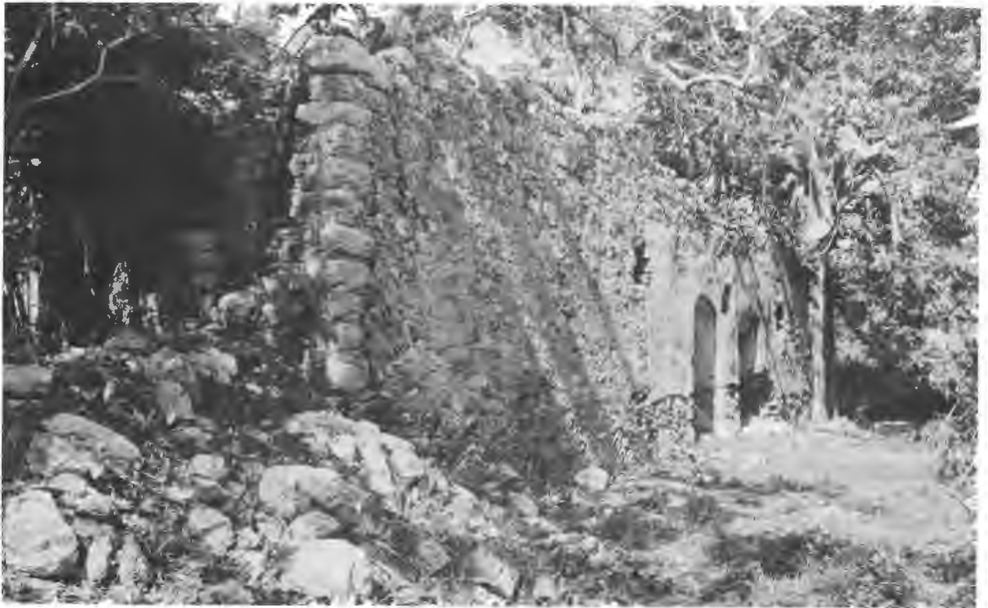
9. Fachada oriente de la casa.
