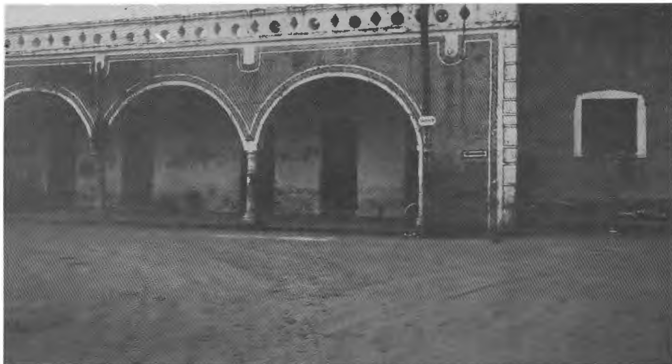
Una de las arquerías de la plaza. La delicadeza de esta pintura fue destruida, totalmente falseada en las obras de 1993.
