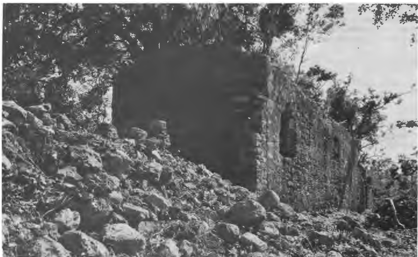
11. Fachada poniente de la casa.
