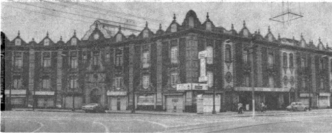
Fig. 38. Edificio Gaona: conjunto de viviendas construido por el arquitecto Torres Torija en 1922, en la calle de Bucareli, Colonia Juárez. Ejemplo notable de arquitectura "neocolonial", con paramentos de piedra, tezontle y azulejo y decoración barroca, además de las efigies de Hernán Cortés y varios virreyes, por lo que se enfrenta agresivamente con su casi vecino, el Palacio Cobián.
