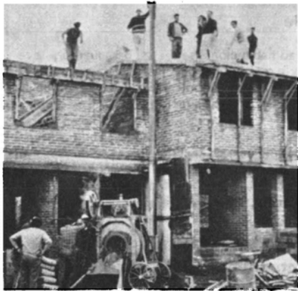
Fig. 30 (arriba). Proceso de construcción de un conjunto habitacional para un grupo cooperativo de obreros textiles. Un capataz y varios miembros de la cooperativa.
