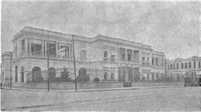
Fig. 37. Fotografía de la época del Palacio Cobián, construido en los primeros años del siglo por el ingeniero Sánchez Facio, y que actualmente aloja a la Secretaría de Gobernación. Calle de Bucareli, en la Colonia Juárez.
