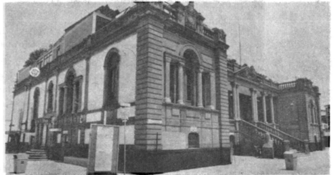
Fig. 35. Palacete aristocrático en la Colonia San Rafael, ocupado actualmente por la Universidad del Valle de México. Junto con otros edificios próximos nos revela la elegancia y distinción que poseyó esta zona de la colonia.
