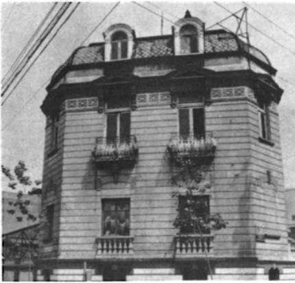
Fig. 30. Pretencioso y copetudo edificio, remedo de mal gusto de la arquitectura francesa. Fue durante algún tiempo residencia arzobispal. Colonia San Rafael.
