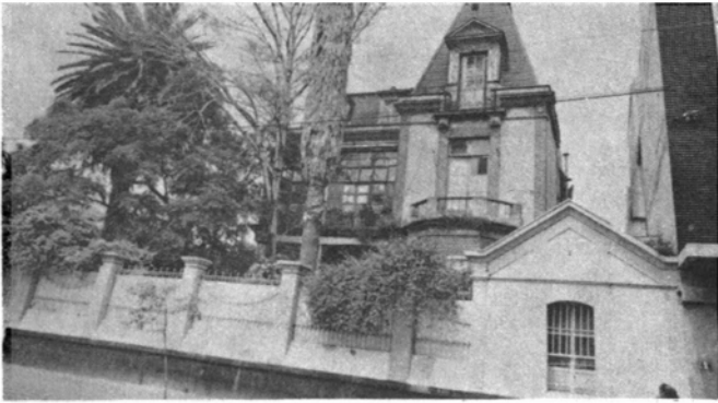
Fig. 24. Ejemplo excepcional de villa o chalet afrancesado en la Colonia Santa María. Fueron excepción las familias que construyeron estos tipos de edificios en esta colonia.
