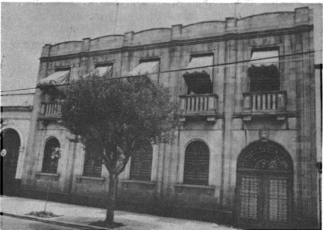
Fig. 44. Edificio del arquitecto E. Weber, de 1926, en la Colonia Roma. Uno de los últimos ejemplos de lo que, con reservas, podemos calificar de "arquitectura doméstica porfirista".
