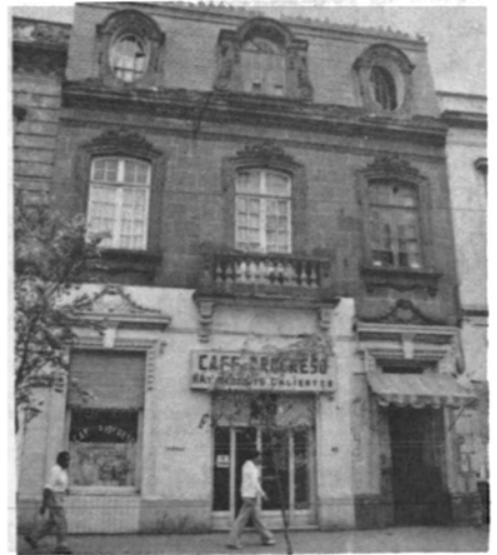
Fig. 19. Edificio con cubierta en mansarda: ejemplar único de este tipo en la Colonia Guerrero.
