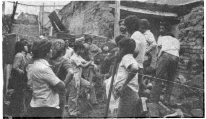
Fig. 5. Derrumbe durante la temporada de lluvias de una vecindad (calle Sol 168). Miembros de la Cooperativa "Guerrero" retirando los escombros. A la fecha la vecindad continúa parcialmente habitada y semiderruida, por no haberse llegado a un acuerdo con el dueño para hacer las reparaciones necesarias.
