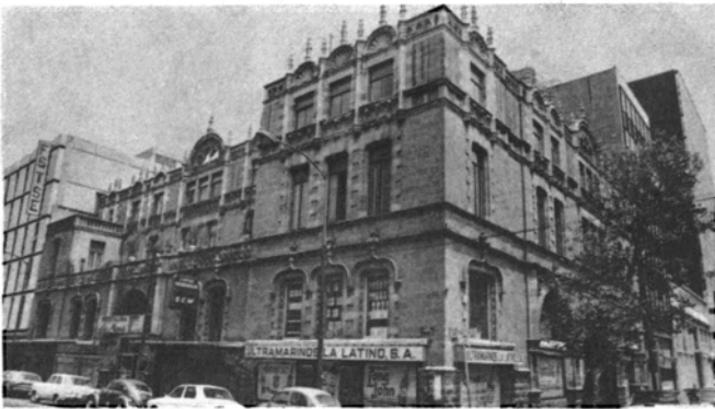
Fig. 32. Edificio señorial construido a principios de siglo para el gobernador del Distrito Federal, De la Landa y Escandón. Es uno de los ejemplos más notables del eclecticismo goticista. Ubicado en la Colonia San Rafael.
