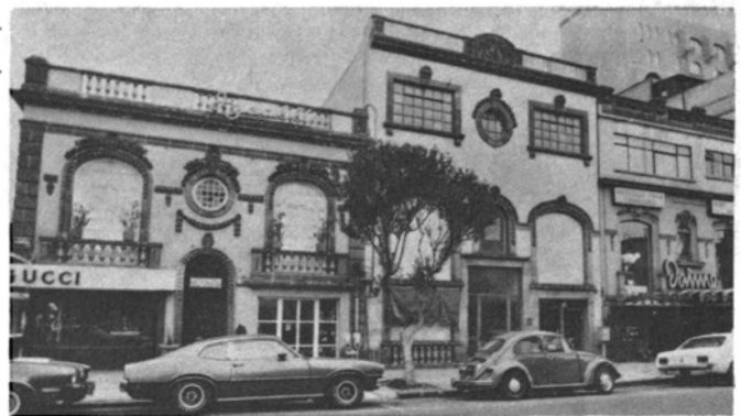
Figs. 40-41. Ejemplos del uso comercial que actualmente se da a los antiguos edificios de vivienda de la Colonia Juárez, en el sector de la "Zona Rosa".
